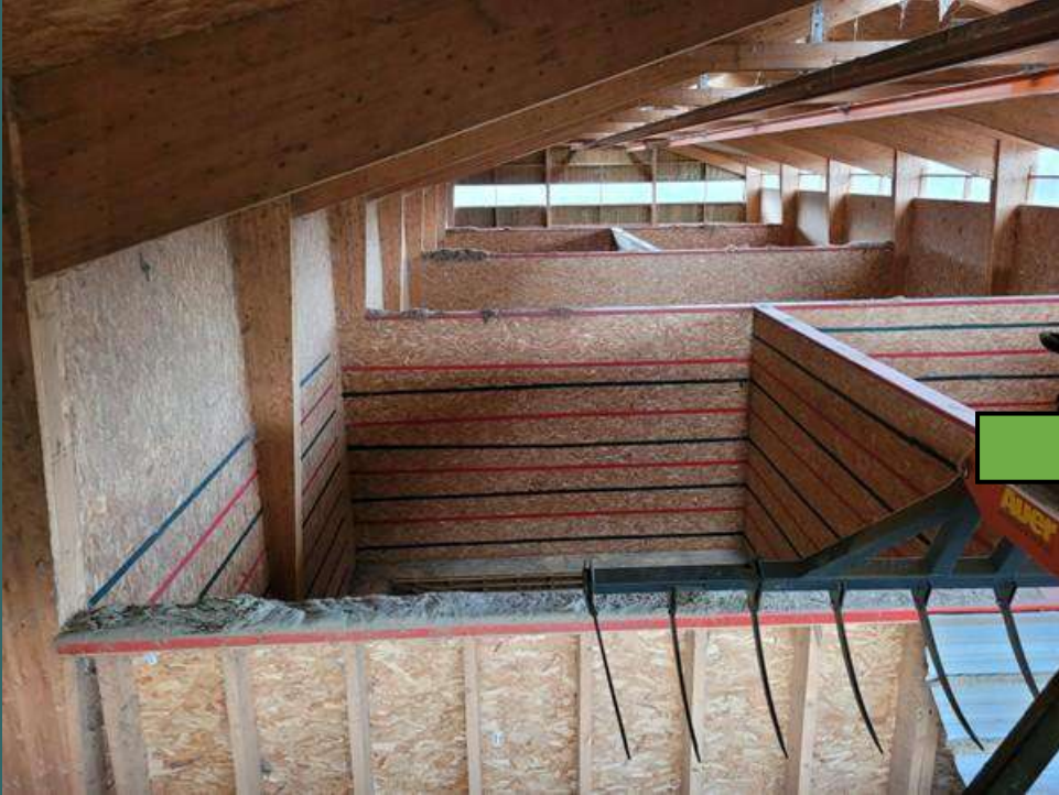
Stockage dans des cases de 100 à 200 m 2
